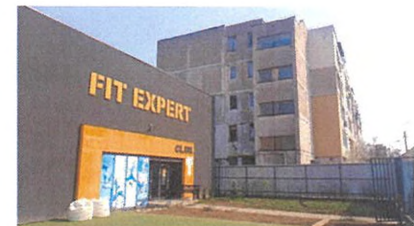
Vedere SUD - existent
