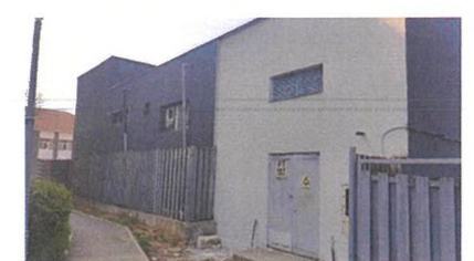
Vedere EST - post trafo existent
